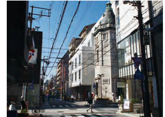
写真-11 信号機撤去後
