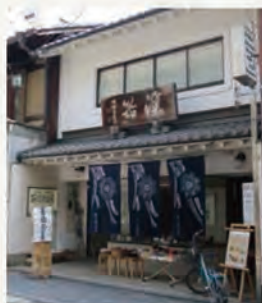
西村吉象堂 界わい景観建造物
