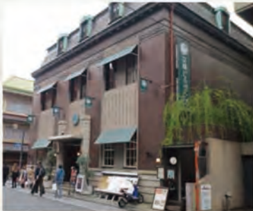
文椿ビルヂング（旧西村貿易店） 国登録有形文化財
