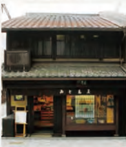
みど寿屋 界わい景観建造物
