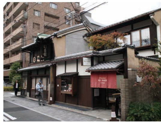
写真-2 道路整備後（2015年）
