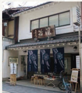
西村吉象堂 界わい景観建造物
