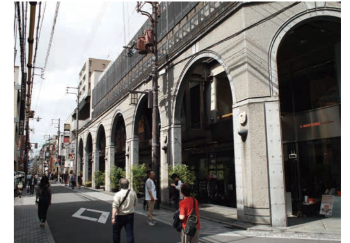
洋風の様式を取り入れた斬新なデザイン
